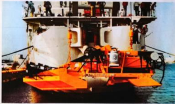
Arado para enterramiento del cable.
